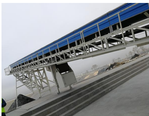
固化物输送廊道
