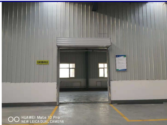
废包装容器清洗车间
