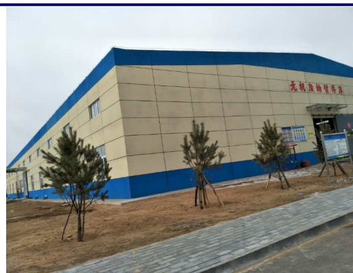
无机废物暂存库
